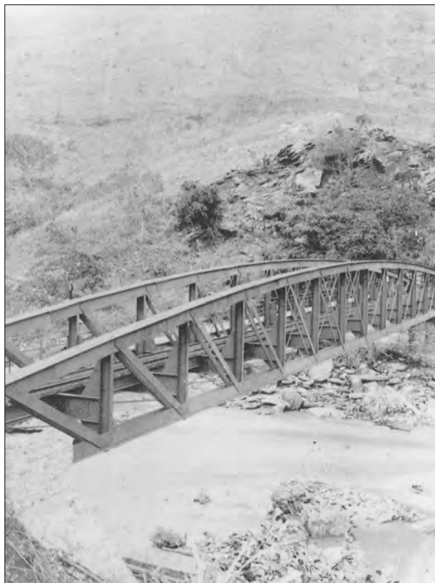
Franchissement de la Mpozo au km 8.
