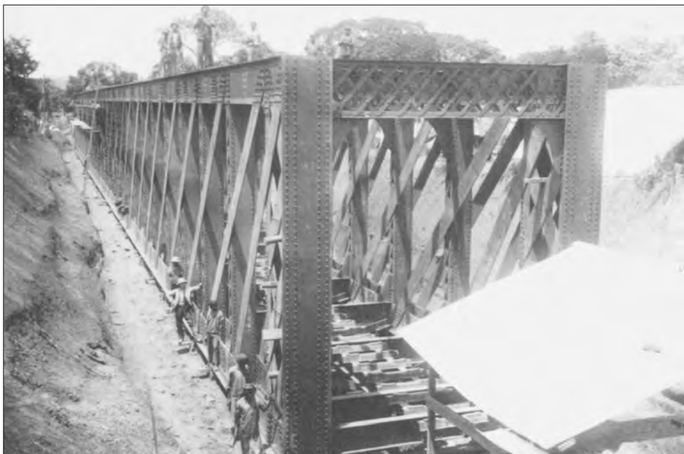
En février 1898, le pont métallique en voie d'achèvement dans sa tranchée.
