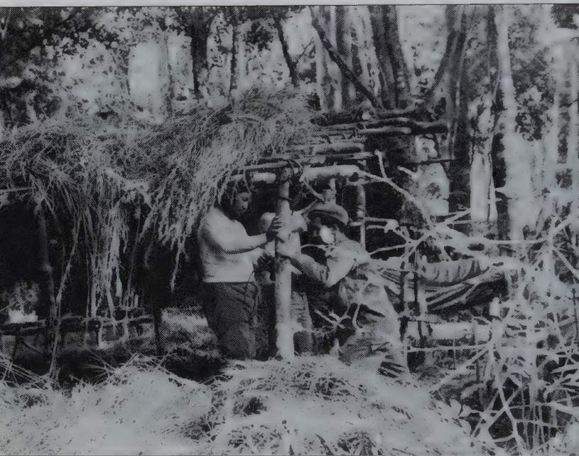
Installation du camp de base de Lulimba.
