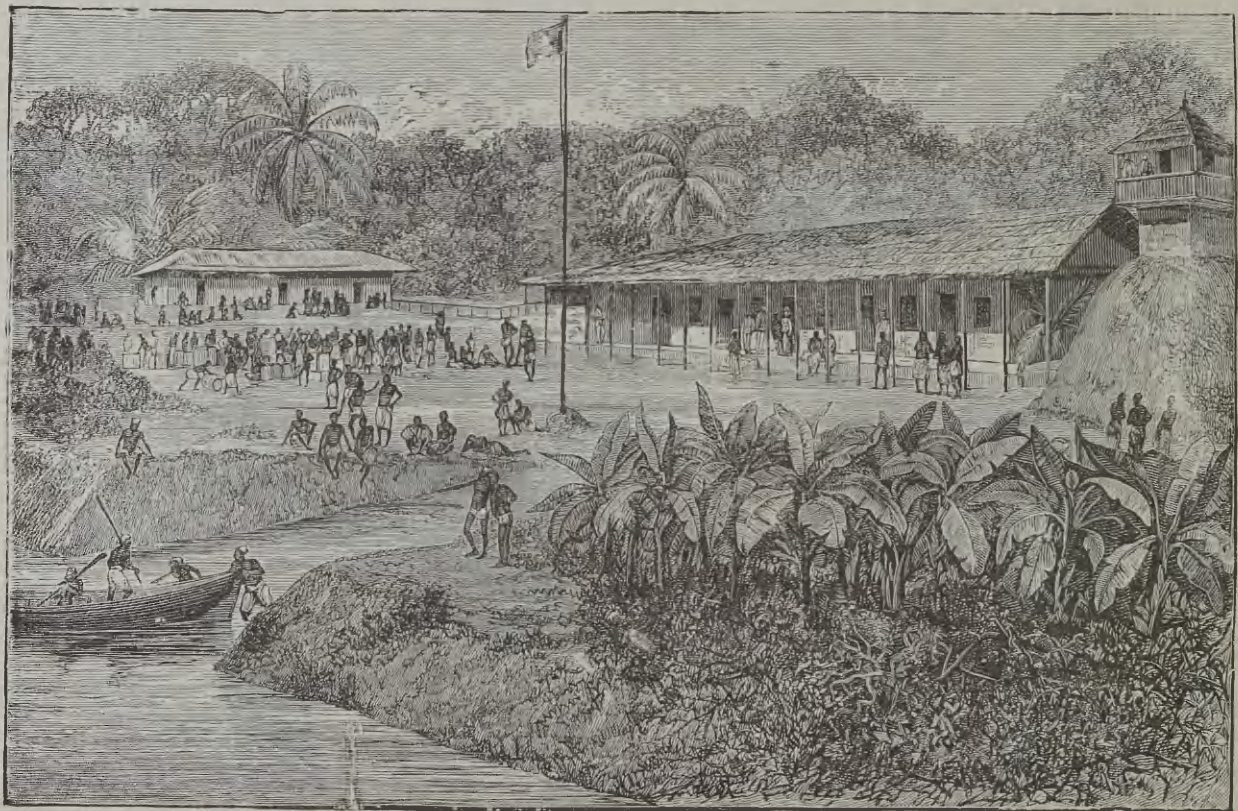
VUE PARTIELLE DE LA STATION DE L'ÉQUATEUR.
