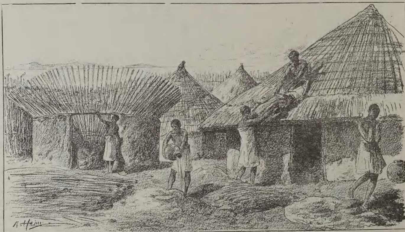
CONSTRUCTION D'UN VILLAGE.
