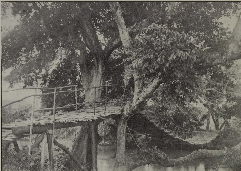
PONT SUSPENDU SUR LA RIVIÈRE LUKUNGA.
