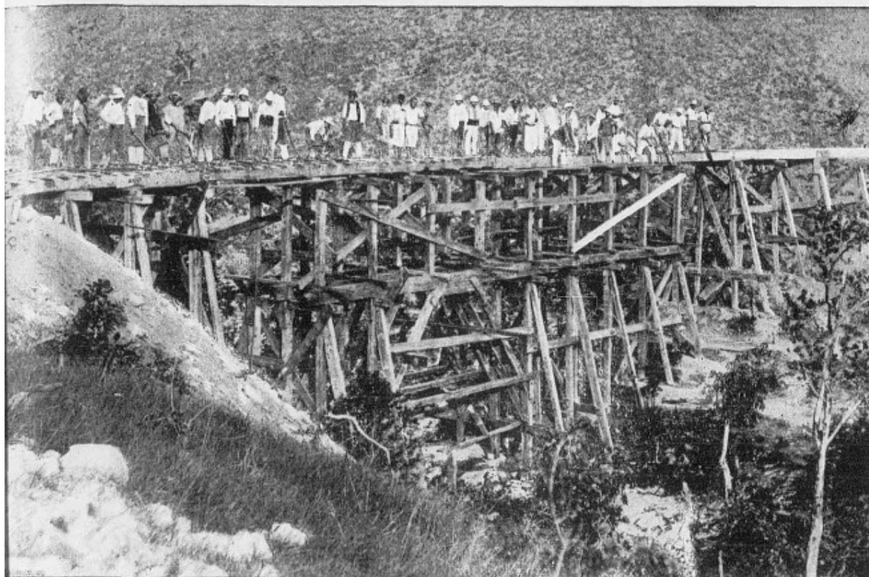
Dans le massif de Palaballa : Pont de service.
