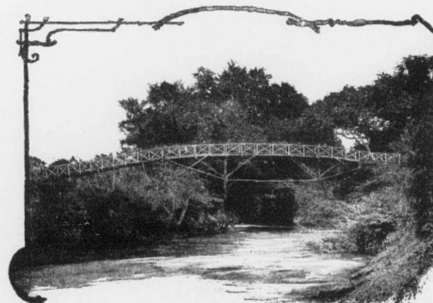
Pont sur la Loukouna.
