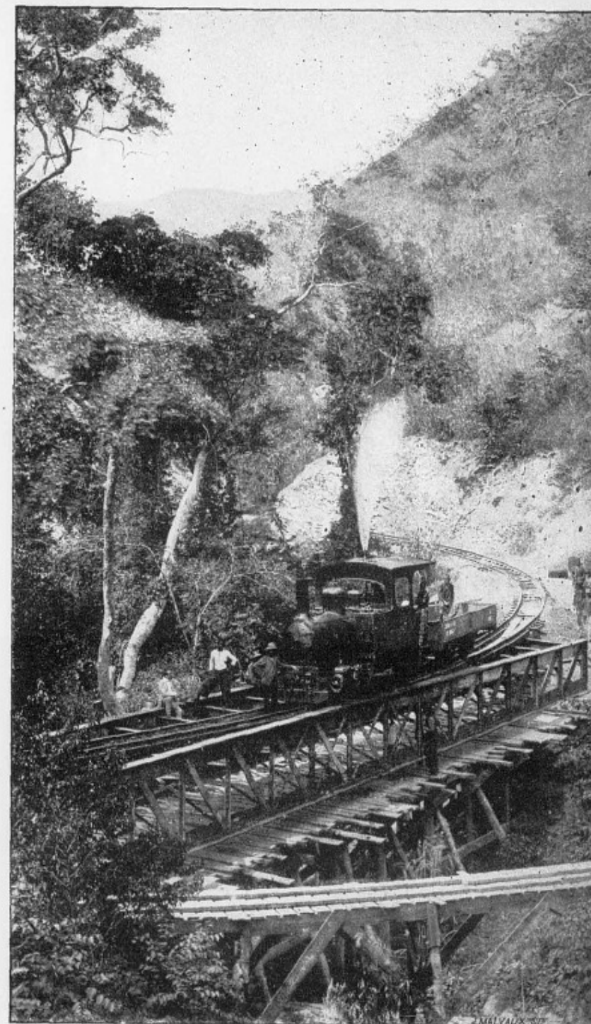
Et durant qu'à l'avancée les tranchées s'ouvrent, les wagonnets Decauville circulent, en arrière, c'est la locomotive enfin qui roule victorieuse, éveillant, comme ici, les échos du ravin du Sommeil.
