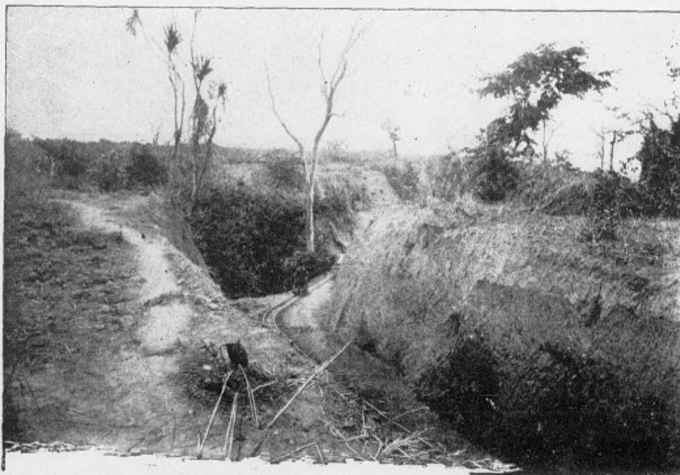
Tranchée de Kengbé da Lemba, au kil. 30.
